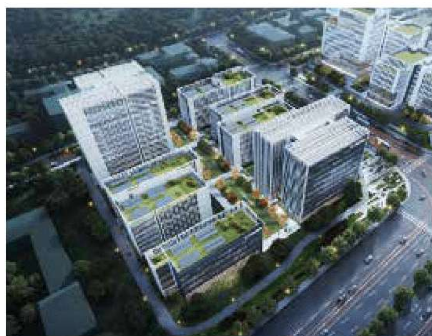
集团总部 Headquarters building
